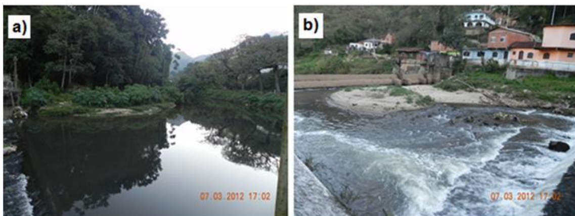
Figura 5.13 - a) Vista do reservatório; b) Jusante do reservatório
