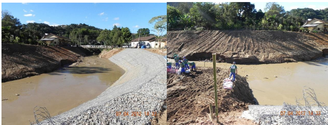
Figura 3.4 – Obras no rio Santo Antônio
