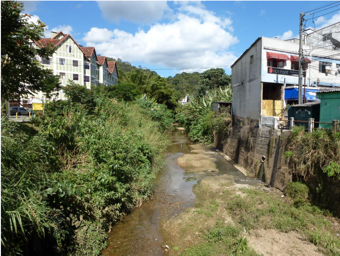
Figura 1.1 - Lançamento de esgoto doméstico na cidade de Petrópolis
