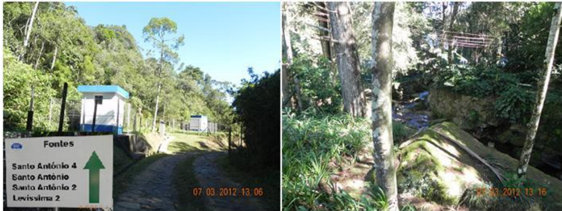
Figura 5.4 - Vista das casas de captação de água da NESTLE P06
